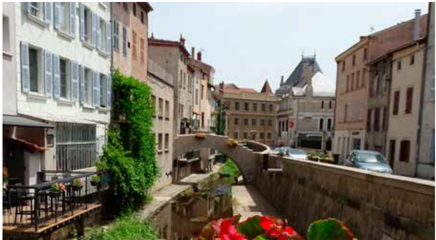
Ponts enjambant le Vizézy. Source : Ville de Montbrison
