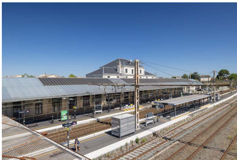
Gare de Libourne © Direction de la communication ville de Libourne - La Cali
